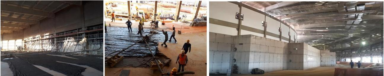
Figura 22: Concretagem simultânea de parede e laje do túnel com traço de concreto auto adensável no Linac, lançamento por 5 bombas e 10 linhas de tubulação com dispositivo de controle de fluxo tipo guilhotina e concreto aparente do túnel de blindagem
