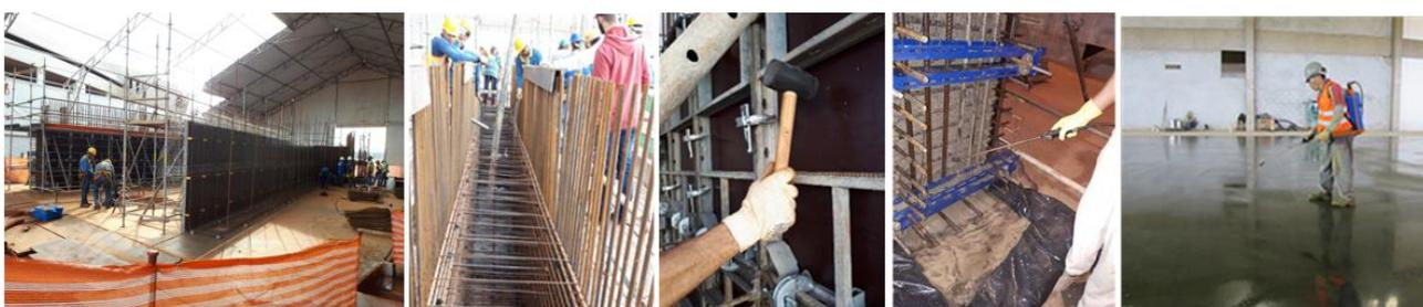
Figura 20: Treinamento para equipes de forma e armação, lançamento de concreto em camadas com espessura controlada, para vibradoristas e aplicação de retardador de superfície para executar corte verde nas juntas de concretagens entre as placas de piso e paredes do túnel (gavetas) e agente de cura química a base de resina polimérica
