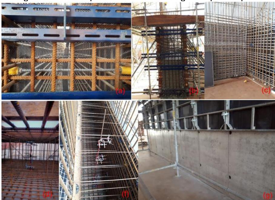
Figura 15: (a, b) teste de forma com tela de aço expandida, (c) teste de armadura de pele, tela de vidro e tela metálica, (d) instrumentação da placa de piso Tipo B e parede do túnel com extensômetros elétricos de corda vibrante e rosetas, (g) teste de agente desmoldante e aparência do concreto.
